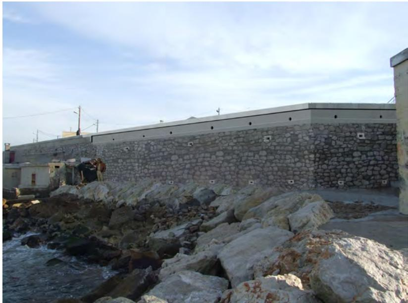
Le mur de soutènement de l'anse du Bain des Dames à la Pointe rouge s'est effondré lors des dernières grandes pluies de 2009. À l'occasion de cette réfection, la DIFRA souhaite établir un modèle de mur qui puisse être utilisé sur différents sites côtiers. Le mur outre ses fonctions techniques et les obligations d'économie de réalisation doit apparaître comme un élément qualifiant du paysage marseillais.
